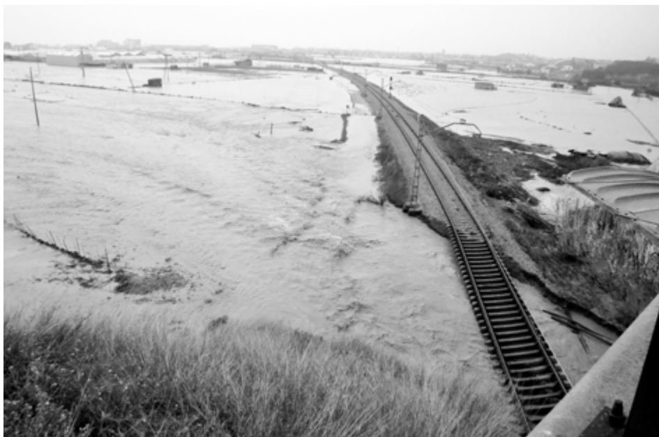
Fig. 3. La zona agrícola del Pla de Grau inundada (delta de la Tordera, Malgrat de Mar), vista des del pont de la carretera BV-6001 vers l'oest. S'aprecia el descalçament del talús ferroviari de la línia R1 amb uns rails que han perdut tot el balast.
